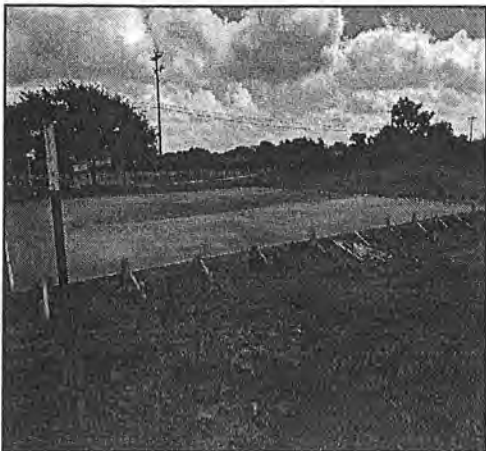
1. Pour concrete slab
